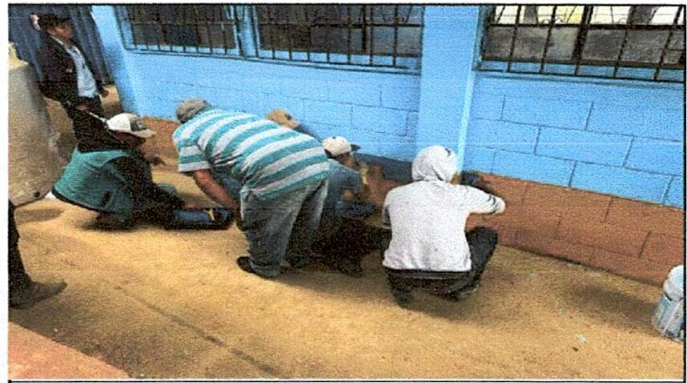
Foto 10: Trabajos de pintura por parte de padres de familia. Muros exteriores.
