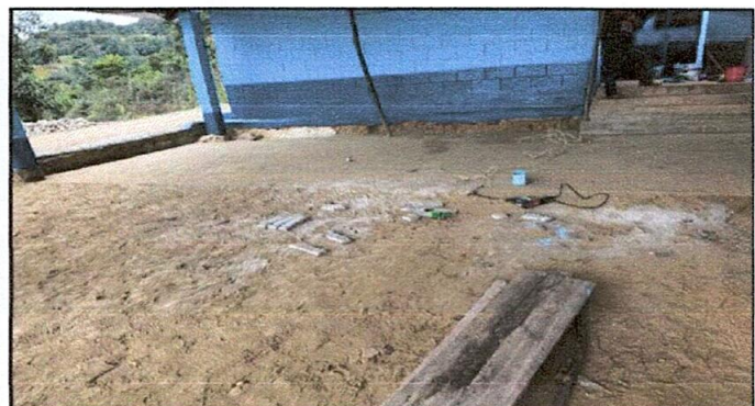
Foto 12: Patio general del establecimiento antes de iniciar los trabajos de losa en la misma.
