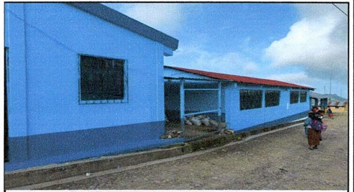
Foto 2: Pintura externa de los muros del establecimiento.
