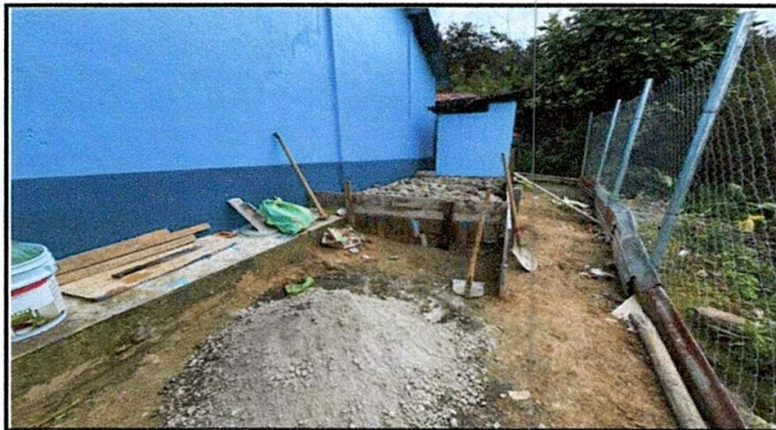
Foto 3: Mezcla y aplanado del terreno para aplicación de la losa del patio trasero.
