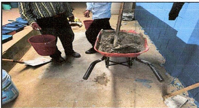
Foto 11: Inicio de trabajo en losa general de patio del establecimiento.
