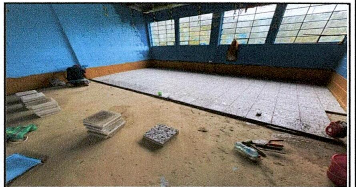
Foto 6: Vista de un aula con la mitad de piso de granito puesto.
